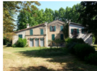
la façade Sud de la bastide
